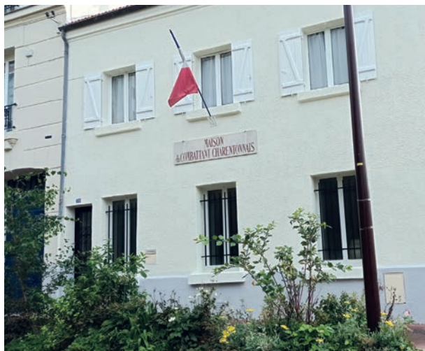
Le ravalement de la façade de la Maison du Combattant, rue des Bordeaux, est à présent terminé.
